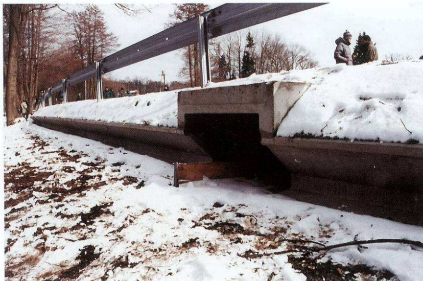
Zdjęcie 2 – Przejście dla płazów z profilowanych prefabrykatów betonowych [Jędrzejewski W., Nowak S., Kurek R. Mysłajek R., Stachura K., Zawadzka B.; „Zwierzęta a drogi” - Zakład Badania Ssaków PAN, Białowieża 2006]
