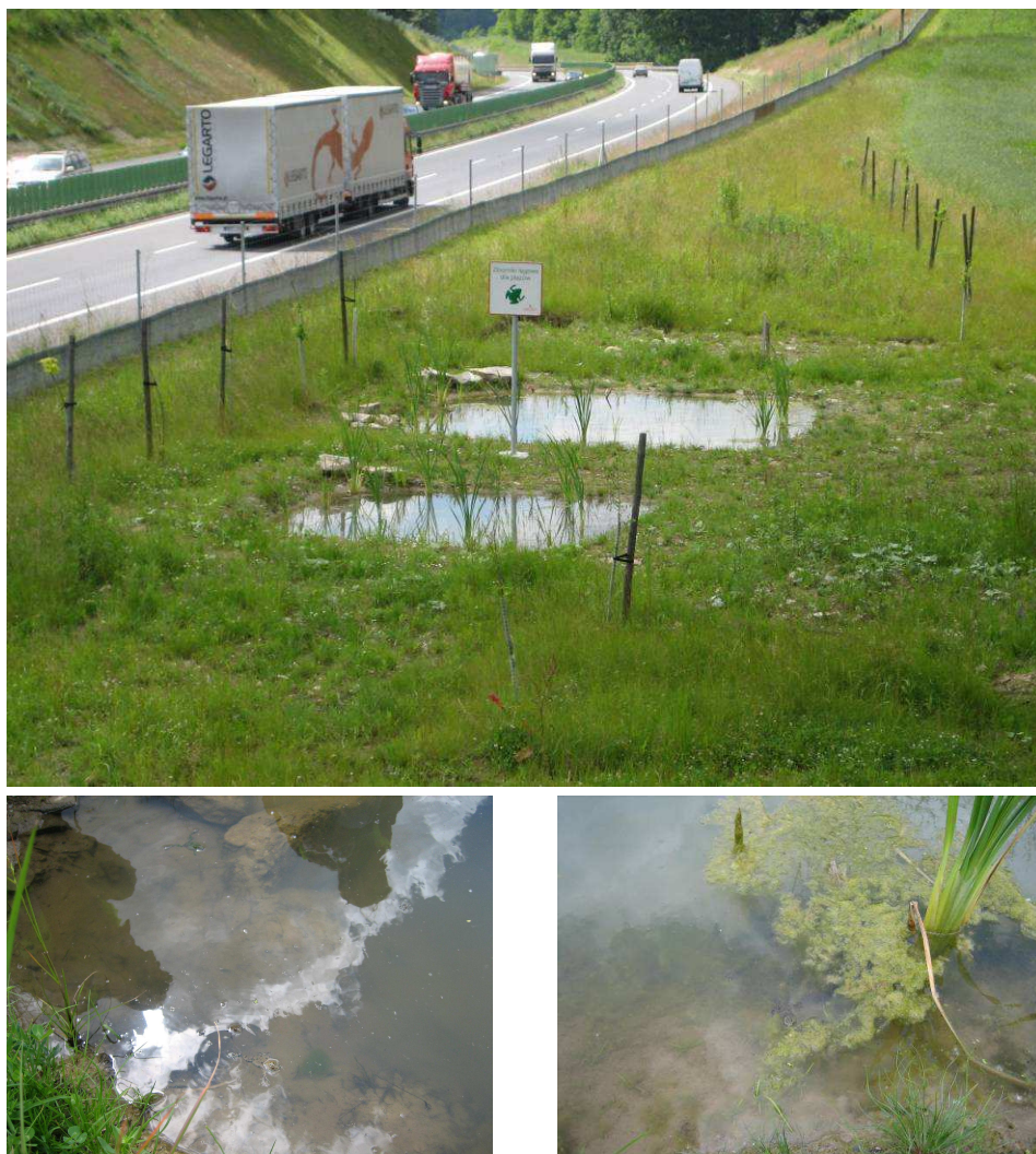
Fot. 5. Budowa zbiorników kompensacyjnych umożliwi płazom przystąpienie do rozrodu.
