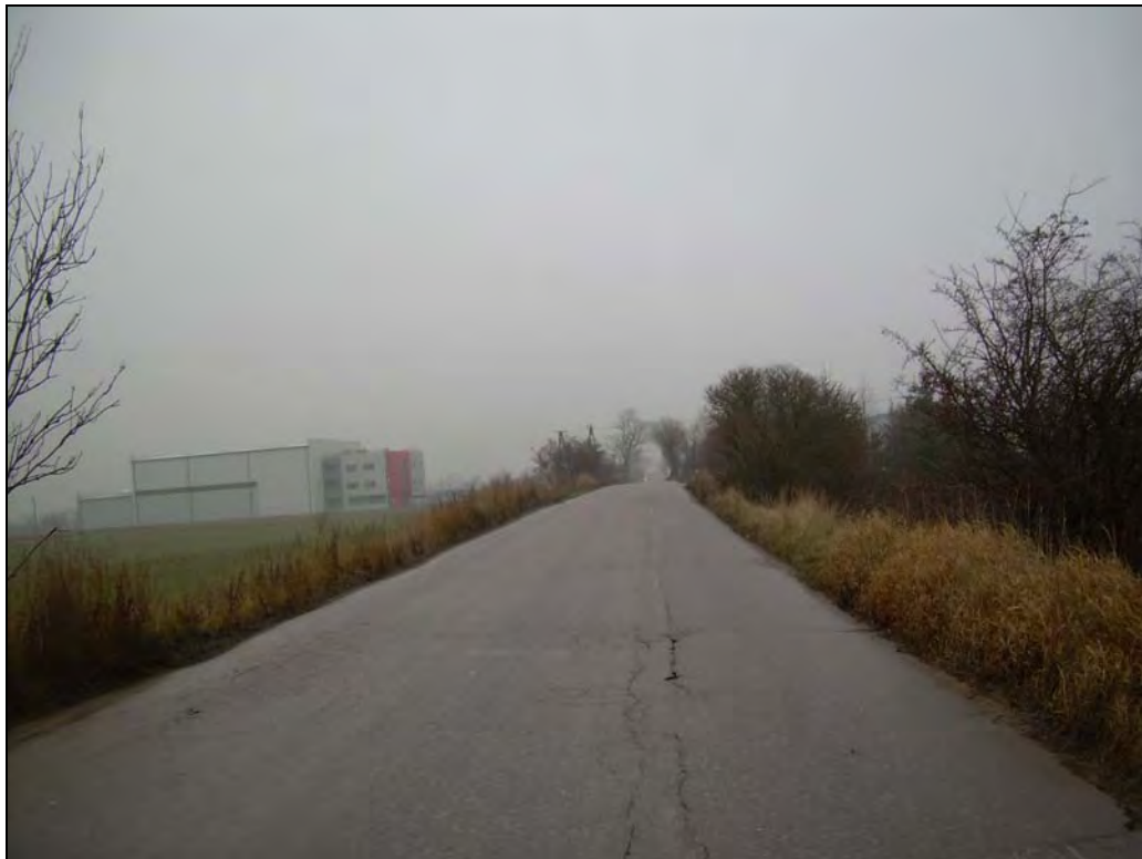
Fot. 107. Stan środowiska w grudniu 2008 r.: km 33+750, droga przez Gdańsk-Rębiechowo; miejsce projektowanego węzła „Lotnisko” w wariantcie C, podwariantcie południowym C2
