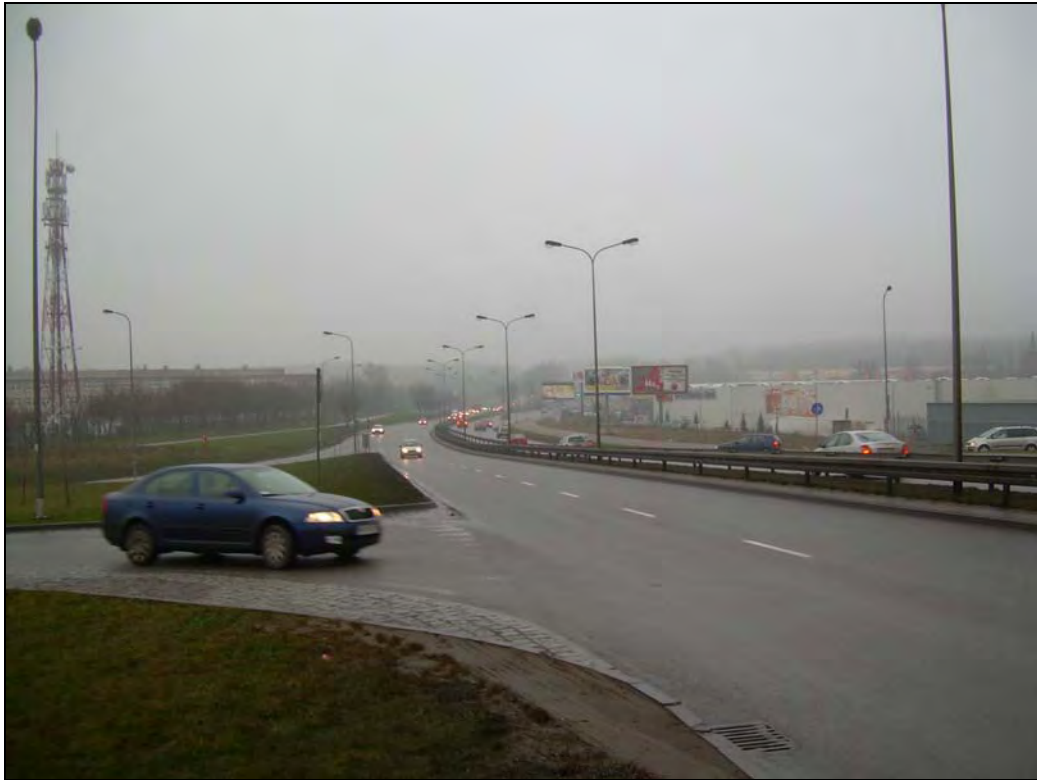
Fot. 112. Stan środowiska w grudniu 2008 r.: km 37+000, ul. Słowackiego w węźle „Matarnia”; po prawej centrum handlowe Matarnia; miejsce projektowanej trasy S6 w wariantcie C
