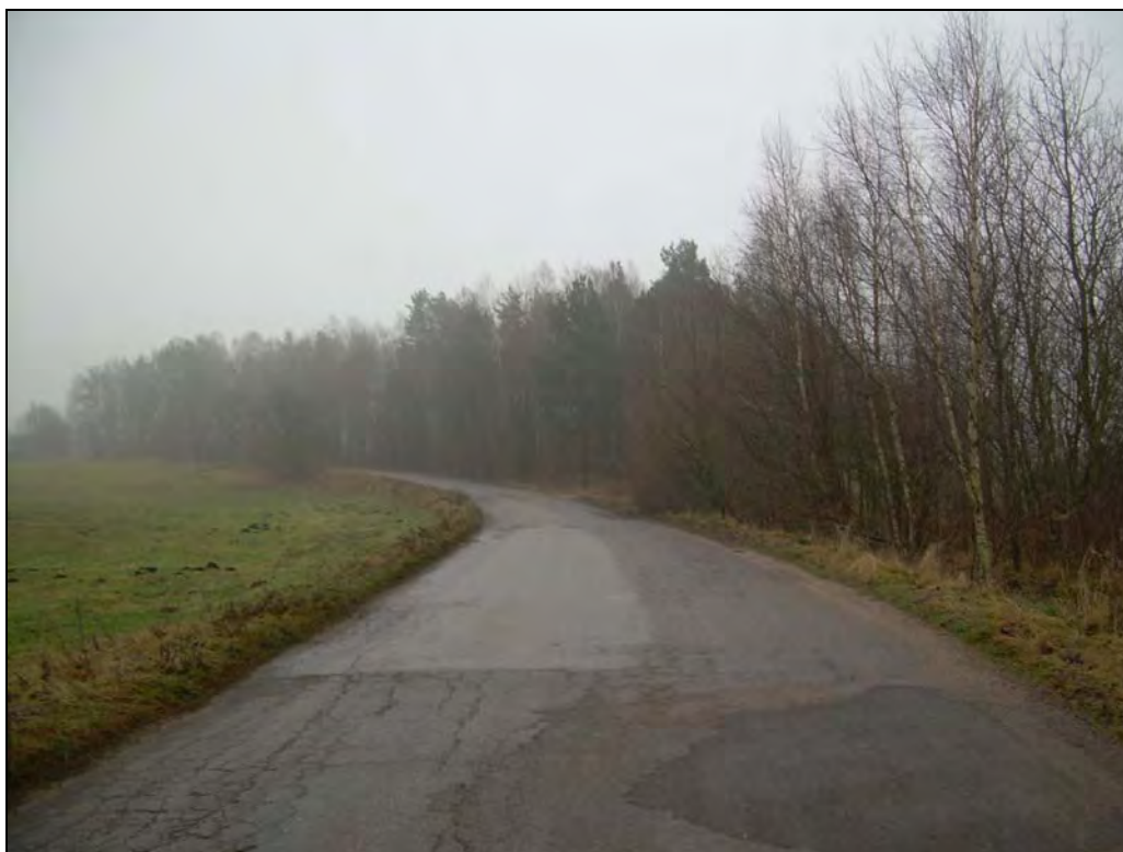
Fot. 81. Stan środowiska w grudniu 2008 r.: km 16+400, droga z Jeleńskiej Huty do Kowalewa
