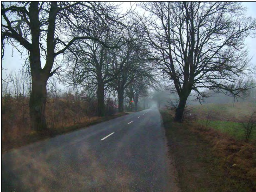
Fot. 69. Stan środowiska w grudniu 2008 r.: km 18+800, droga Szemud-Chwaszczyno w Kielnie; w poprzek miejsce projektowanej trasy S6 w wariantcie A1
