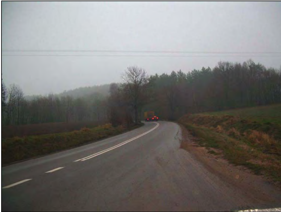
Fot. 66. Stan środowiska w grudniu 2008 r.: km 16+400, droga Szemud-Chwaszczyno w Kieleńskiej Hucie; w głębi w poprzek miejsce projektowanej trasy S6 w wariantcie A1
