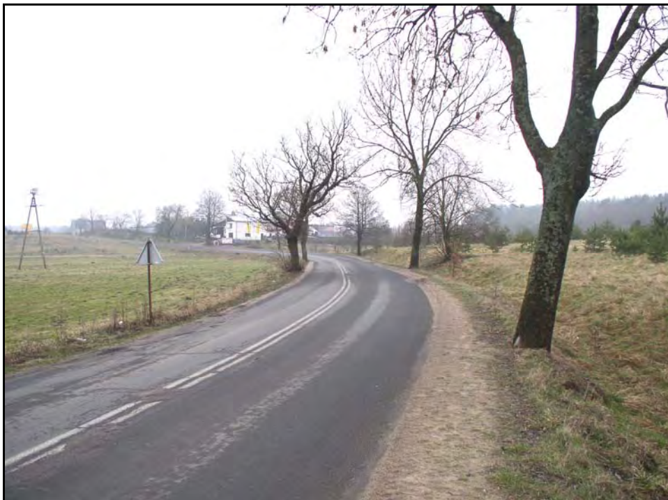
Fot. 71. Stan środowiska w marcu 2007 r.: km 19+200, droga nr 218 w Koleczkowie/Bojanie (ul. Wybickiego)
