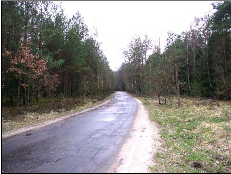
Fot. 45. Stan środowiska w marcu 2007 r.: km 26+350, Las Strzebieliński w Strzebielinie przy drodze do Paraszyna; na pierwszym planie w poprzek miejsce projektowanej trasy S6 w wariantie II
