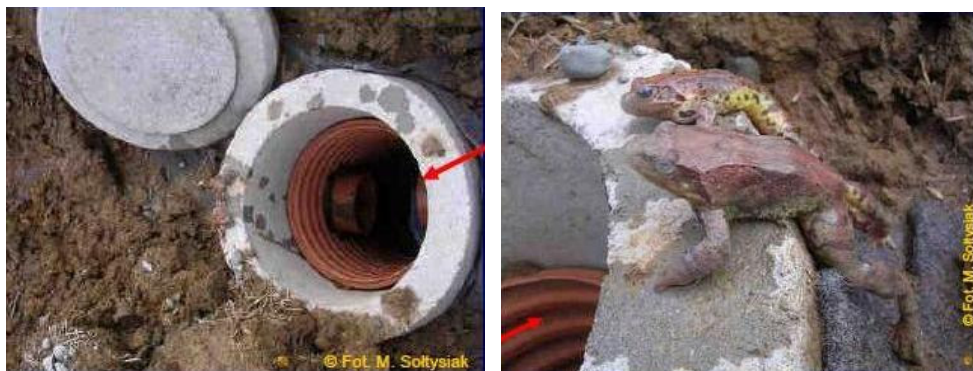
Ryc.17.2.1c. Przykład sytuacji jakich należy unikać: pułapki powstałe podczas budowy drogi, płazy utopione w studziencie odwodnieniowej, fot. M. Sołtysiak.
