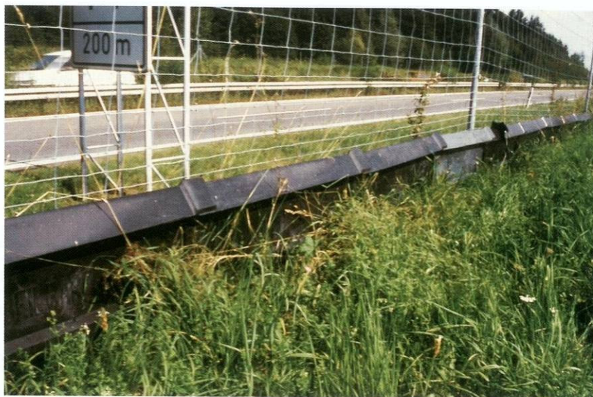
Zdjęcie 1 – Plastikowa zapora wkopana w ziemię i uniemożliwiająca przechodzenie przez drogę płazom i gadom oraz małym ssakom [Jędrzejewski W., Nowak S., Kurek R. Mysłajek R., Stachura K., Zawadzka B.; „Zwierzęta a drogi” - Zakład Badania Ssaków PAN, Białowieża 2006]
